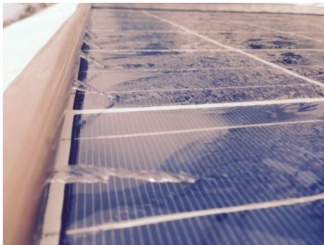
Fig. 10: Sistema de refrigeração instalado e funcionando em um conjunto de painéis fotovoltaicos.
