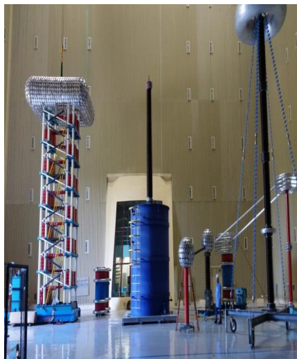
Figura 05 – Equipamentos para ensaios elétricos no LACEN.
