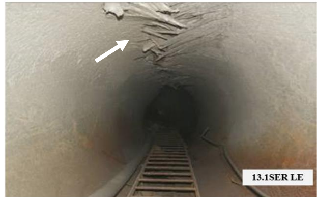
Figura 3: Problema de Quebra mecânica (“ breakout ”). Fonte: Tropia (2013).
