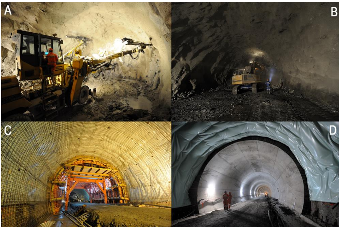
Figura 9 – Algumas das atividades inseridas no processo construtivo do Túnel do Marão: (A) Furação da frente de escavação; (B) Saneamento da frente de escavação; (C) Betonagem do revestimento definitivo; (D) Geomembrana de impermeabilização e troço já revestido
