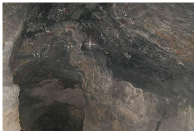
Figura 6. Galeria de desenvolvimento em região de dobra. A galeria apresentou indícios de instabilidade sendo necessária a reinstalação de suporte depois de alcançado o dobro de sua altura dimensionada.
