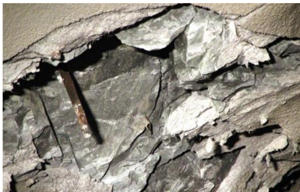
Figura 6. Cratera formada pelo evento de rockburst .
