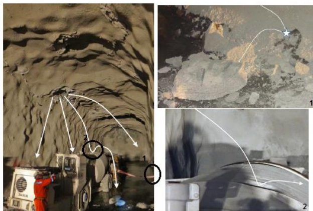
Figura 9. Zonas de impacto dos blocos ejetados.
