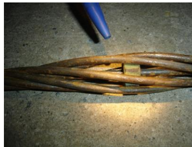
Figura 11: Cabos de Aço e suas porcas espaçadas a cada metro ao longo do comprimento do mesmo.
