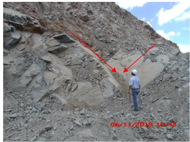
Figura 8 Ruptura em cunha nos taludes do lado Direito prestes a ocorrer. Foto obtida em novembro de 2013, Mello (2014). As rochas fragmentadas acima e o material saprolítico escorregou em dezembro de 2013.
