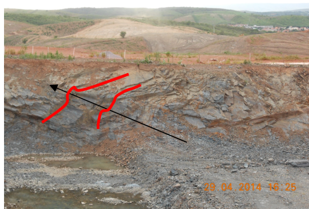
Figura 5 - Dobramentos ao Longo do Canal de Restituição. Estacas 6 e 7. Lado Esquerdo Hidráulico.
