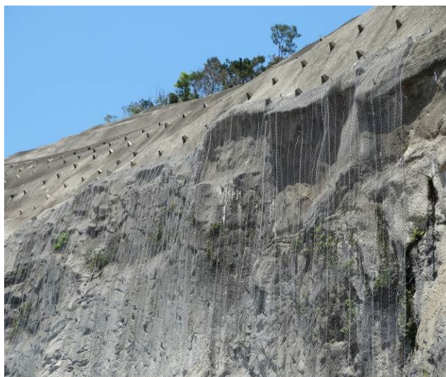
Figura 8. Detalhe da transição entre telas SteelGrid HR50 e DT.
