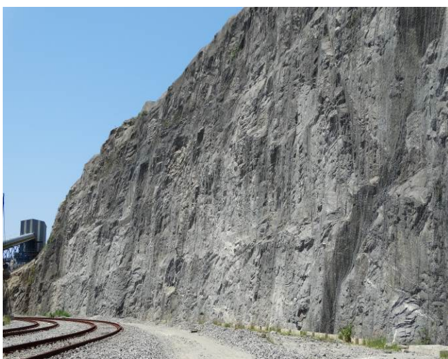
Figura 6. Vista geral do talude com telas SteelGrid HR50 e DT – Trecho 020°.
