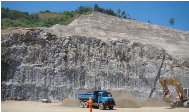
(a) Antes da instalação da infraestrutura do porto
