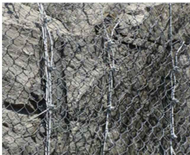
Figura 9. Detalhe dos cabos de aço da tela SteelGrid HR50.
