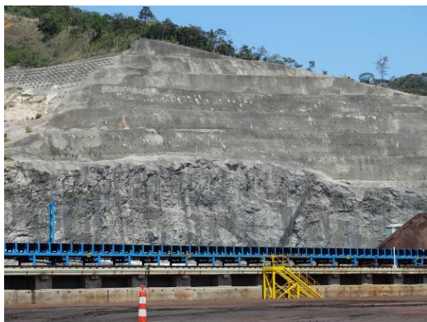
(b) Depois da instalação da infraestrutura do porto
