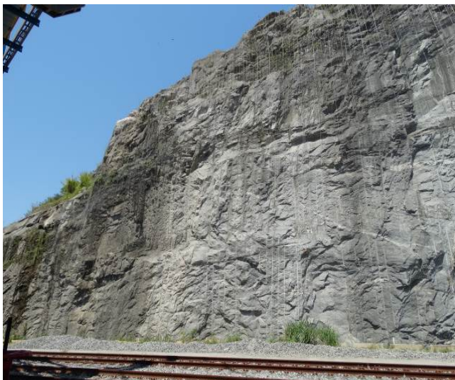
Figura 5. Vista geral do talude com telas SteelGrid HR50 e DT – Trecho 000°.
