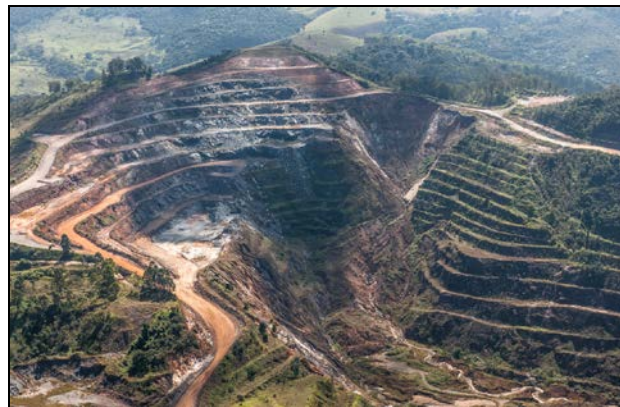
Figura 2. Imagem da cava de Morro Agudo, ruptura e debris no fundo da cava, (Foto tirada em 2014).
