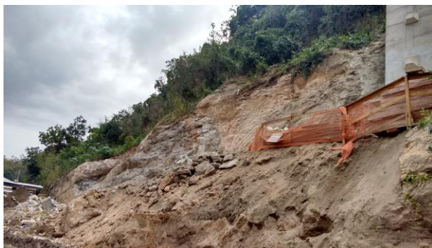
Figura 1. Vista Frontal do Talude.
