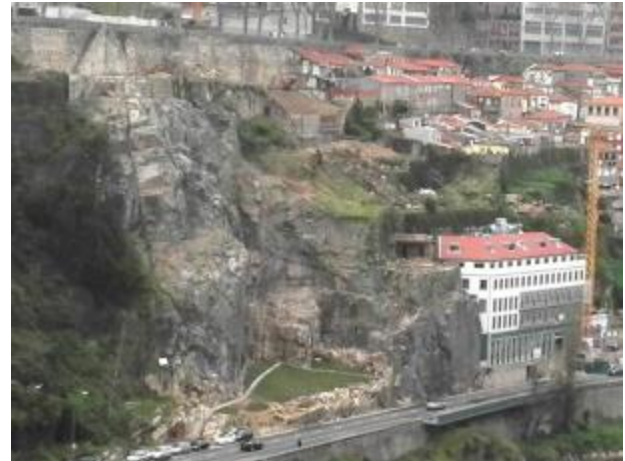
Figura 6. Corte com as soluções adotadas nas secções 3.1 e 3.2 e Fotografia da Secção 3.1 após as obras.
