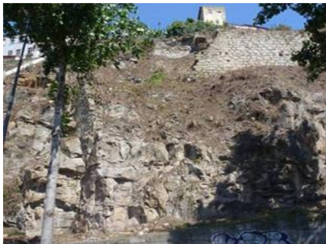
Figura 4. Setor 3. Estado da escarpa e dos muros existentes antes das obras de estabilização.
