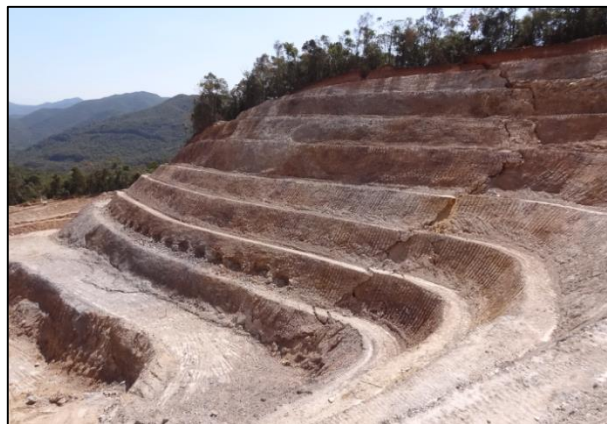
Figura 2: Vista em planta da cava João Burro e da ruptura ocorrida no talude oeste em agosto de 2014.
