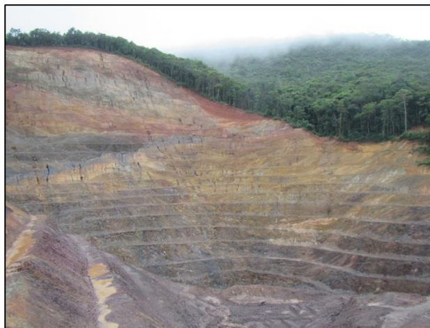
Figura 3: Vista frontal do talude leste indicando a grande variabilidade litológica da cava João Burro.
