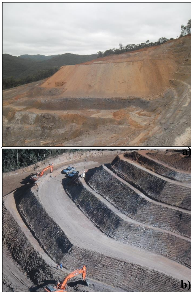
Figura 9: Retaludamento da região oeste. (a) Início dos trabalhos. (b) Região oeste após o retaludamento.
