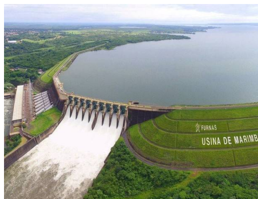
Figura 2 . Barragem de Marimbondo
