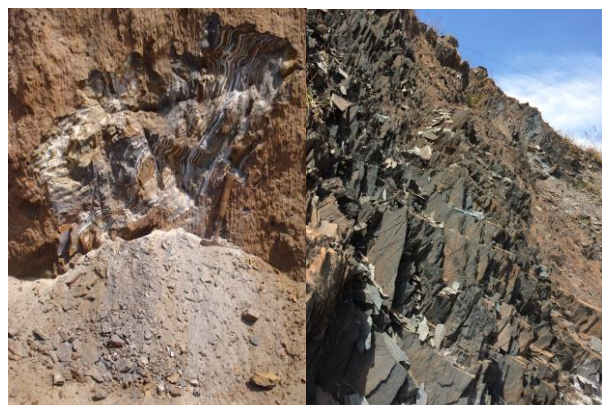
a) b) Figura 10 – Itabiritos friáveis da mina do Sapecado, a) pulverulento goetítico e b) fragmentado, com o bandamento S b ortogonal ao talude e a clivagem S3 em condição favorável a instabilidade.
