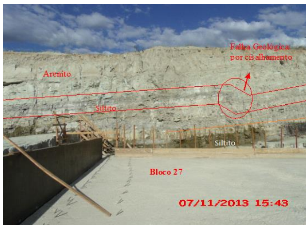
Figura 15 Área do Bloco 27, concretada para início da construção.
