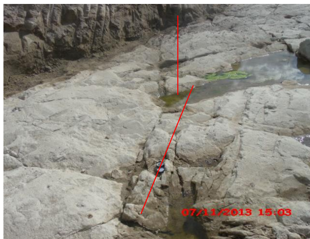
Figura 9 – Zona de Cisalhamento mapeada na escavação da chaveta. A detecção destas feições metamórficas e estrutural gera blocos com séries diversas de fraturamento, podendo estar acompanhadas por falhas geológicas.
