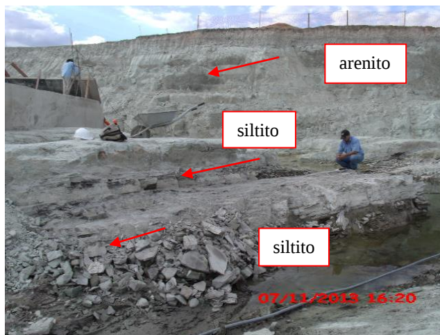
Figura 13 – Mapeamento geológico estrutural de rochas do tipo siltito na fundação da barragem na área da bacia de dissipação, jusante do Bloco 24.
