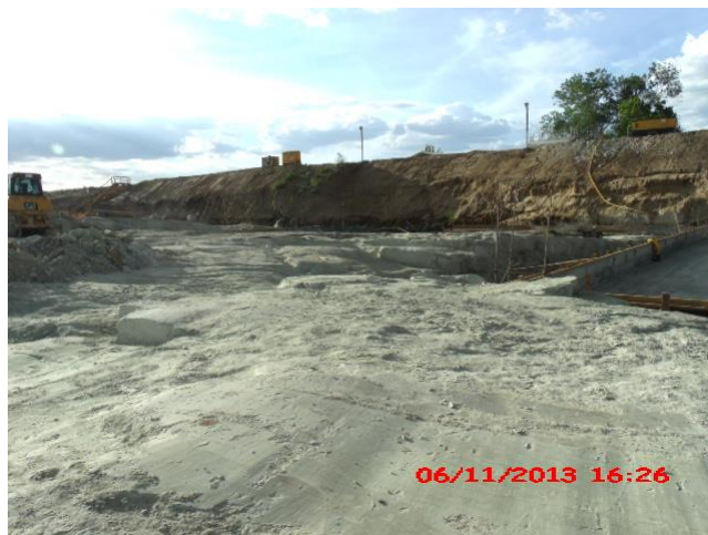
Figura 3. Rochas de fundação do vertedouro na área dos Blocos 13, 14, 15 e parte do bloco 16. Siltito que foi removido da fundação após o mapeamento geológico-geotécnico.
