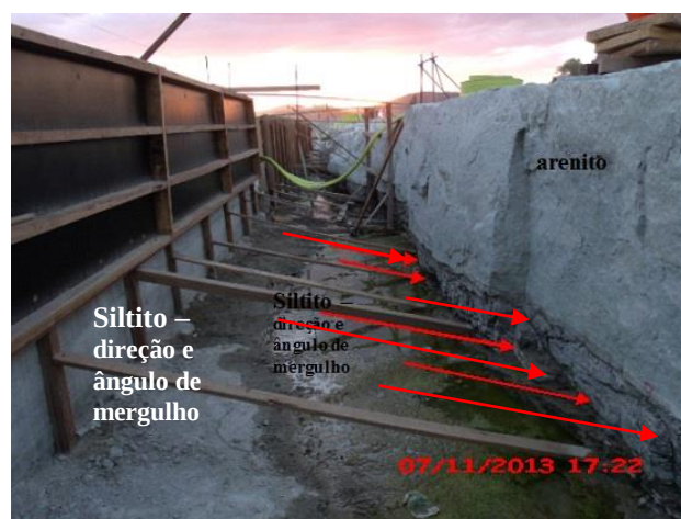
Figura 17 Plano de acamadamento do siltito na base do arenito a jusante Bloco 27
