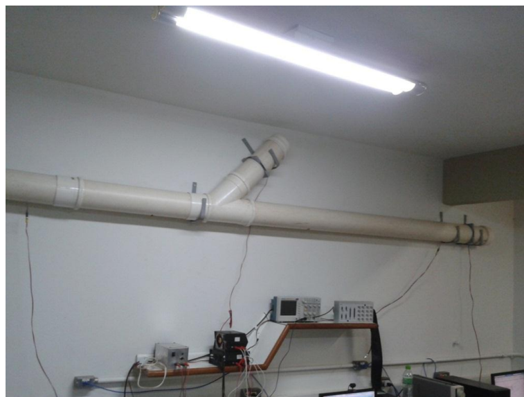
Figura 3. Bancada experimental montada, aguardando adaptação para multicanal.
