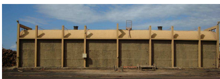
Figura 1: Forno de produção de carvão vegetal RAC220 típico.
