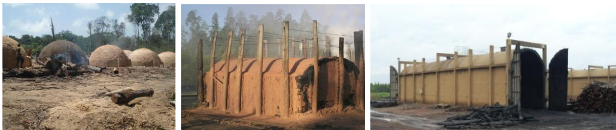
Figura 2: Fornos de Alvenaria: meia laranja, retangular (Amodei, 2008) e RAC220, respectivamente.
