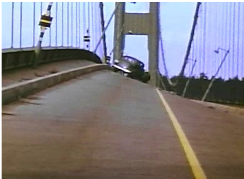
Figura 2: Famoso caso da ponte Tacoma Narrows, onde o efeito de ventos provocou a sua destruição em 1940.
