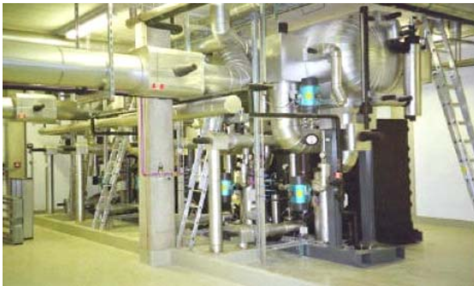
Figura 10. Planta experimental do ciclo de \text{CO}_2 com \text{NH}_3 - Nestlé - Suíça
