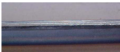
Solda em conformidade, junta de aresta
