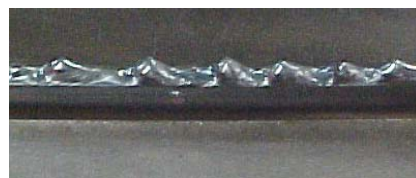
Solda em não conformidade, junta de aresta
