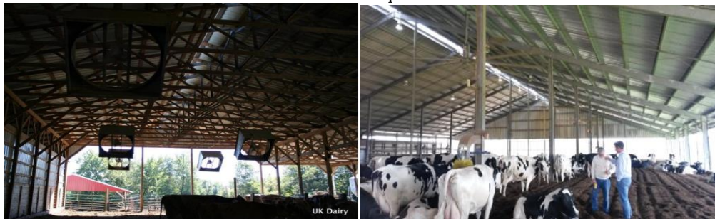
Foto 1 - Galpões com ventiladores de alta rotação e ventiladores HVLS
