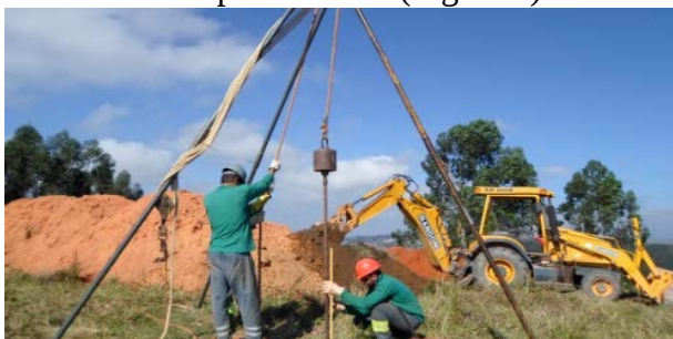
Figura 1. Execução de sondagem SPT
