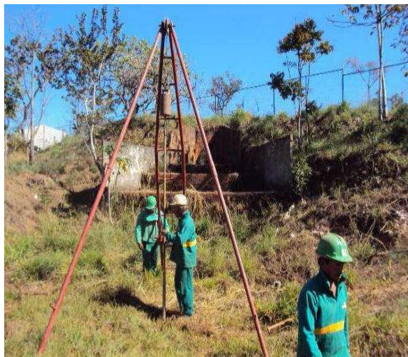
Figura 3. Execução de furos do ensaio SPT
