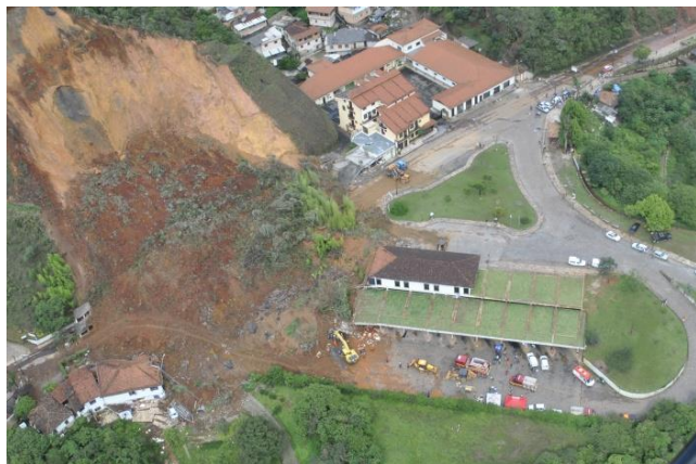
Figura 3. Deslizamento de terra que atingiu a rodoviária de Ouro Preto em 2012 (Foto: Amadeu Barbosa).
