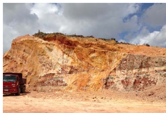
Figura 3. Corte da face do talude estudado com perfil de solo.
