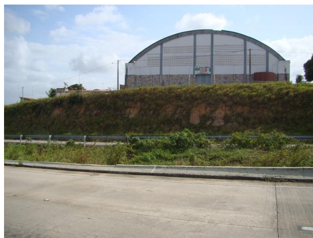
Figura 4. Vista frontal do Talude.
