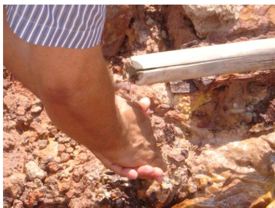
Figura 11. Mina d'água no talude do Corte 25.
