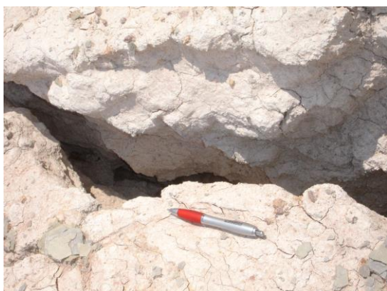
Figura 9. Trincas de tração em berma do Corte 25.
