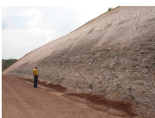
Figura 13. Corte 31 (saturação da base do talude).
