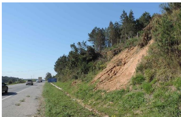
Figura 6. Corte de estrada em arenito fino a muito fino, siltico com feições de erosão e deslizamento.
