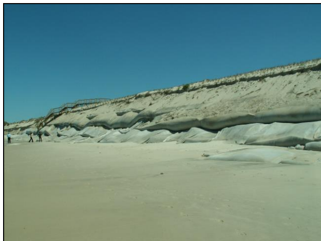
Figura 8. Intervenção com geocolchão na praia de Leirosa, Portugal. Fonte: Carmo (2013).
