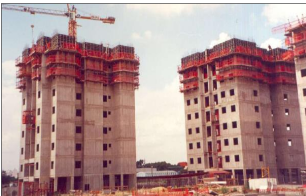
Figura 1. Edifícios de paredes de concreto.
