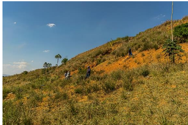
Figura 2. Vista Lateral do Talude estudado.
