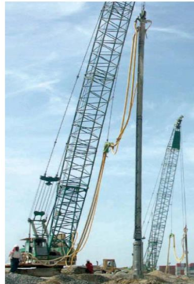
Figura 1. O uso de vibrador para execução de colunas de pedra a partir do topo (DE ALMEIDA, 2014)
