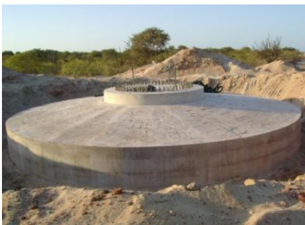
Figura 2. Fundação superficial para aerogeradores.
