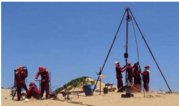
Figura 3. Ensaio SPT no solo de fundação para aerogerador.
