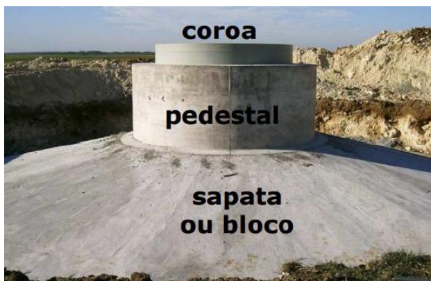
Figura 1. Fundação superficial para aerogeradores.
