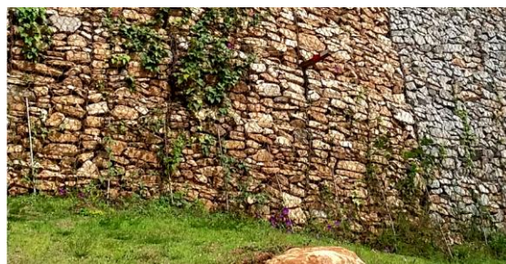
Figura 5. Detalhe das planta trepadeiras plantadas no pé da Contenção II.
