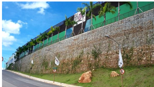
Figura 4. Vista geral da Contenção II.
