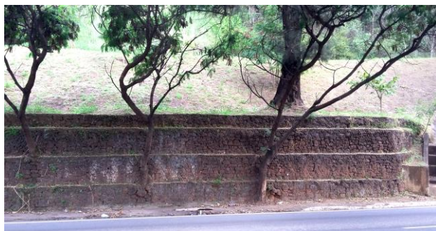
Figura 2. Crescimento de árvores através da Contenção I.
