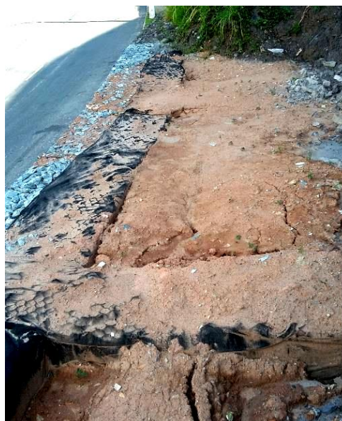
Figura 9. Contraforte no tardo da Contenção IV.
