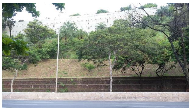
Figura 3. Vista geral do talude da Contenção I.
