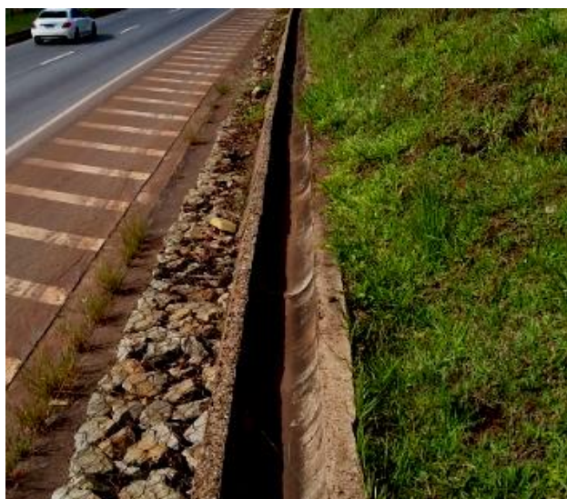
Figura 6. Detalhe da canaleta do sistema de drenagem superficial da Contenção III
