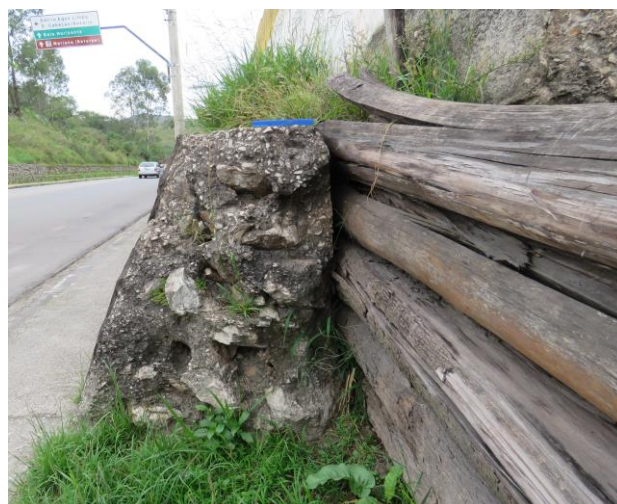
Figura 2. Vista da geometria do muro de concreto ciclópico.
