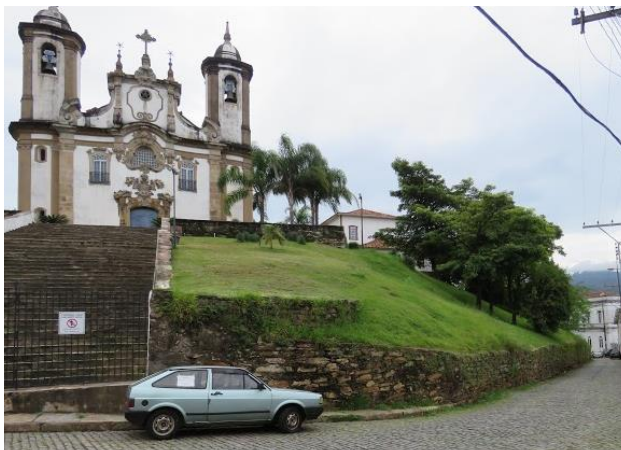
Figura 6. Muro de alvenaria de pedra- Igreja Nossa Senhora do Carmo.
