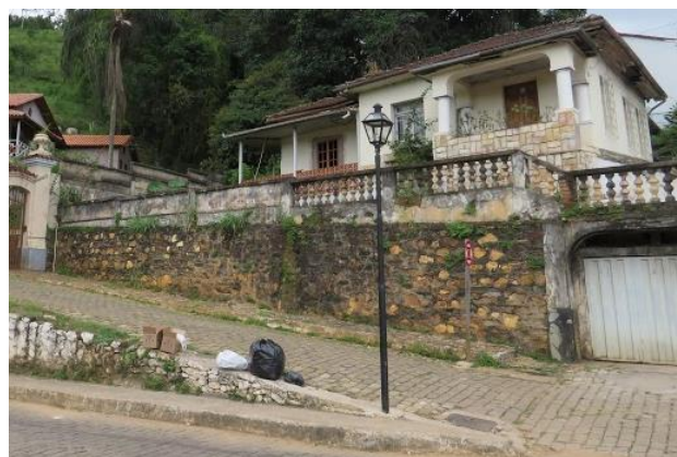
Figura 8. Muro de alvenaria de pedra em Mariana.
