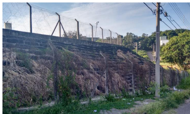
Figura 13. Muro de pneus (vista lateral)- Bairro Dom Cabral- BH.
