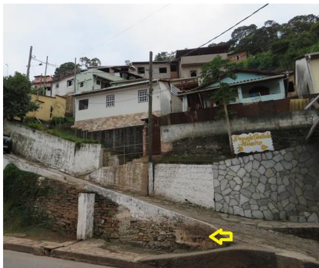
Figura 3. Muro de alvenaria de pedras.
