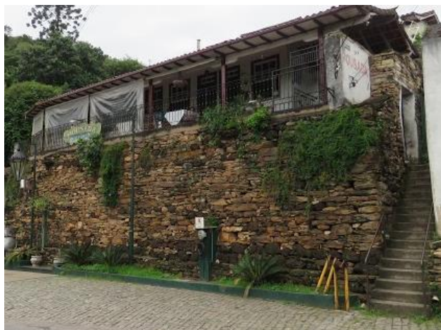
Figura 4. Muro de alvenaria de pedras- Pousada Horto dos Contos.
