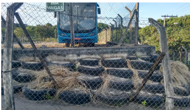
Figura 12. Muro de pneus- Bairro Dom Cabral- BH.
