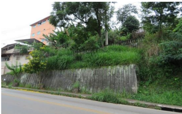
Figura 11. Muro de concreto na estrada Mariana-MG/Ouro Preto-MG
