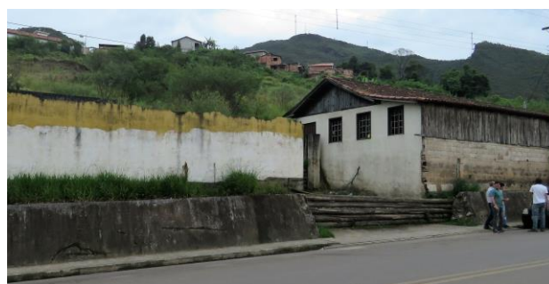
Figura 1. Muro de concreto ciclópico- vista geral.
