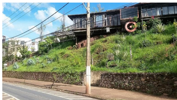
Figura 14. Muro de alvenaria de pedras- Av. Rja Gabágliã.
