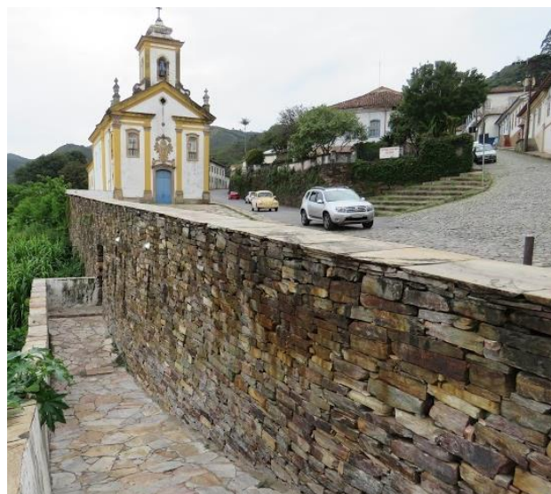
Figura 5. Muro de alvenaria de pedras- Igreja Nossa Senhora das Mercês e Misericórdia.
