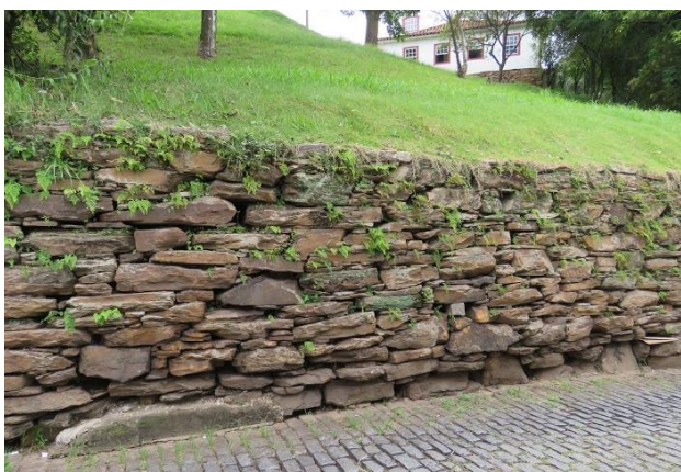
Figura 7. Muro de alvenaria de pedras- Igreja Nossa Senhora do Carmo (vista aproximada).
