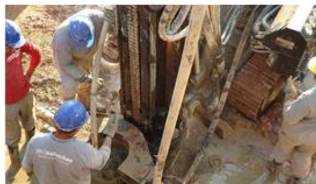
Figura 4. Vista geral das execução das estacas testes.
