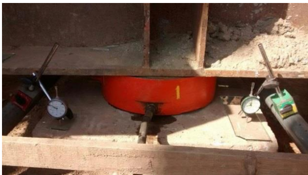
Figura 6. Vista geral do sistema de reação das estacas.
