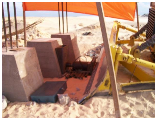
Figura 8: (a) cavalete para ensaio, (b) prova de carga horizontal.
