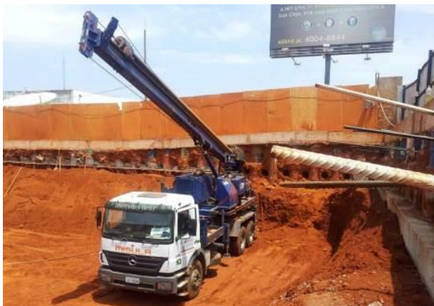
Figura 12 - Caminhão Perfuratriz TM 300 furando o Grampo. Fonte: Mísula Engenharia
