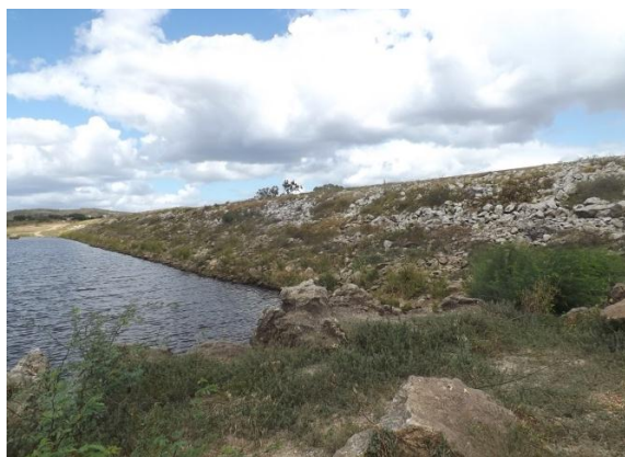
Figura 1. Talude de montante da barragem de Dourado
