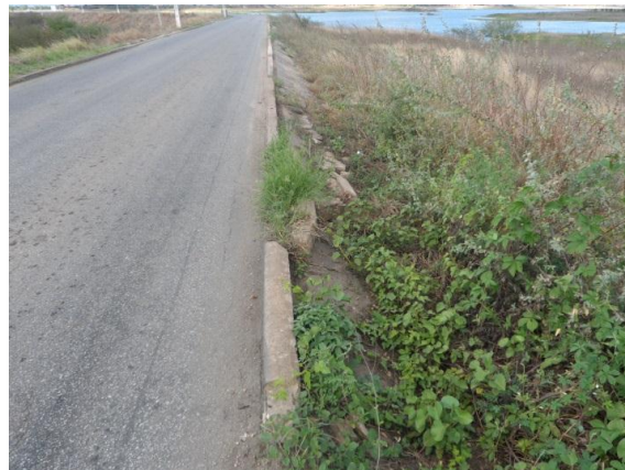
Figura 7. Meio-fio da barragem do Açude Itans
