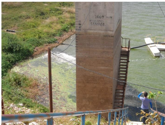
Figura 5. Marcação do nível d'água do reservatório do açude do Boqueirão de Parelhas
