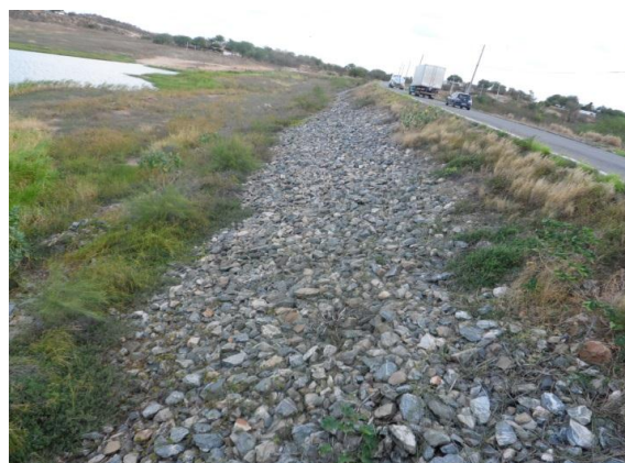
Figura 4. Talude de montante da barragem do Açude Itans
