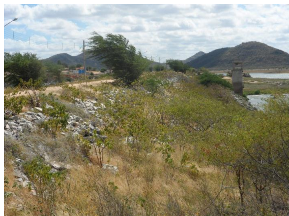
Figura 3. Talude de montante da barragem do Boqueirão de Parelhas
