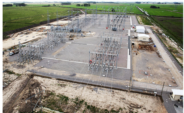
Figura 2. Obra da Subestação Santa Vitória do Palmar A,B - 500/138 KV - Eletrosul (Schreiber Engenharia, 2016)
