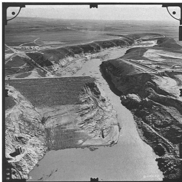
Figura 4. Vista da Ruptura - Barragem de Teton, EUA. (Seed e Duncan, 1987).
