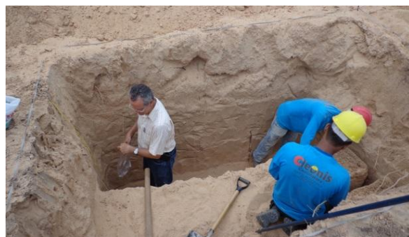
Figura 2. Trincheira para coleta do solo colapsível. Fonte: Torres (2014).
