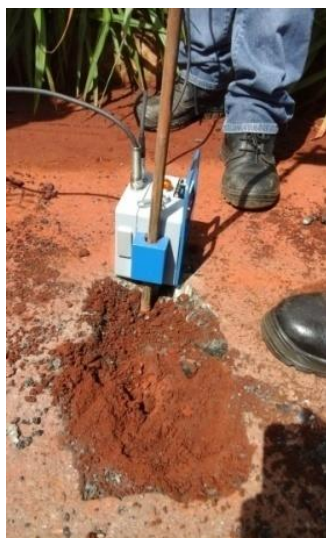
Figura 4. Remoção da camada de revestimento para cravação das hastes.
