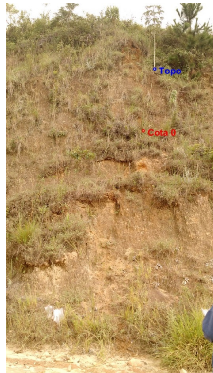
Figura 9: Talude de solo residual; topo colúvio e cota zero início do solo residual
