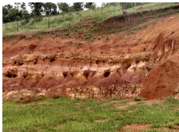
Figura 5: Detalhamento do talude onde foram recolhidas as amostras as 10 amostras
