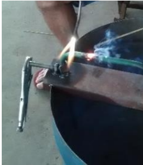
Figura 4. Montagem da tubulação com diâmetro e posicionamento dentro da norma.
