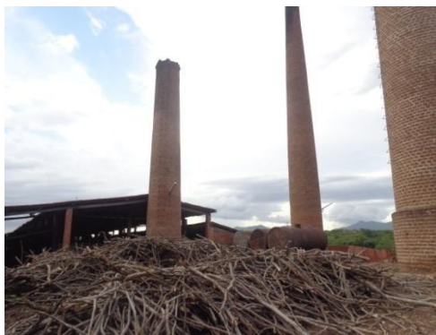
Figura 02: Tanques de 15000litros para óleo BPF e lenha ao lado das chaminés.
