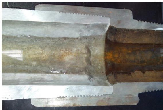
Figura 4. Fotografia da tubulação no estágio inicial do teste.
