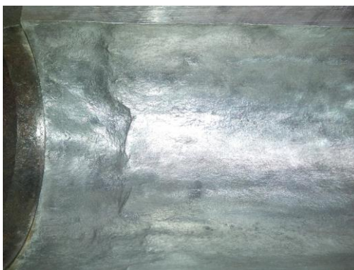
Figura 3. Fotografia da tubulação após a limpeza com escova de aço.
