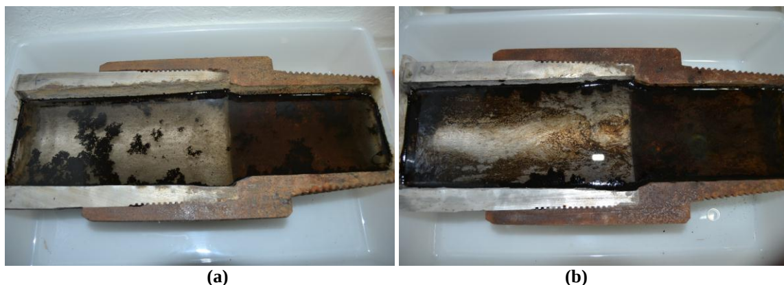
Figura 17. Fotografia da tubulação com desinfetante hospitalar: (a) pincelado nas paredes da tubulação e (b) depositado na água.
