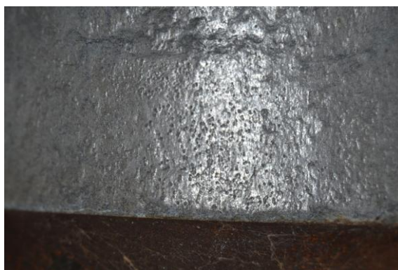
Figura 16. Fotografia da corrosão puntiforme ou por pites, na tubulação.
