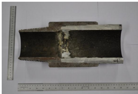
Figura 1. Fotografia da tubulação no primeiro estágio.
