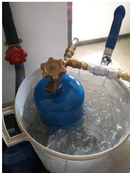
Figura 5. Garrafa com vácuo, aprisionando o refrigerante do condensador
